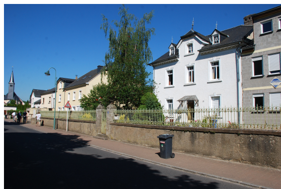
Mur – 21-23, rue de la Sûre
