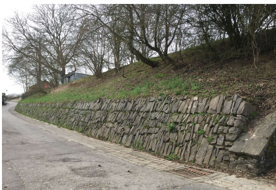
Mur, rue Buerdenerhals
