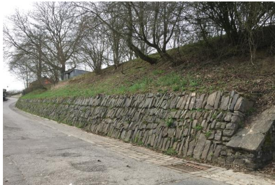
Mur, rue Buerdenerhals
