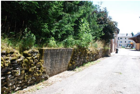
Murs, rue du Moulin
