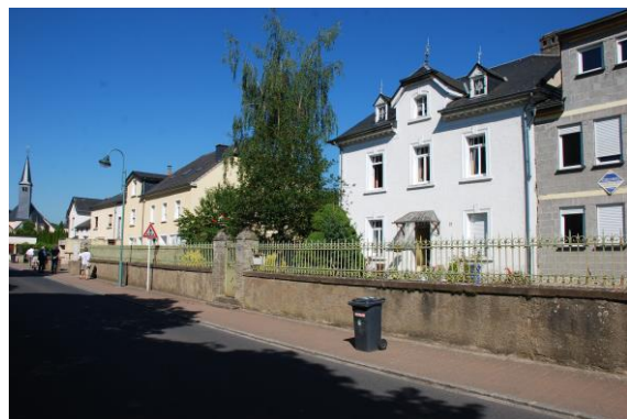
Mur – 21-23, rue de la Sûre
