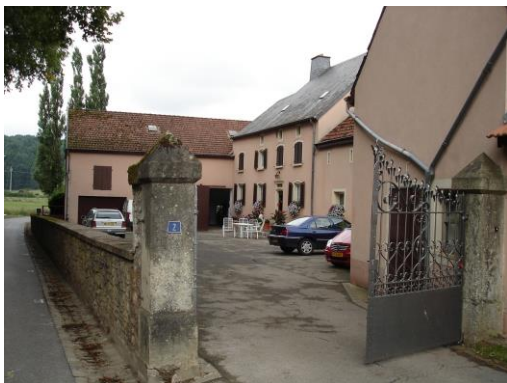
2, rue du Château + mur d'enceinte
